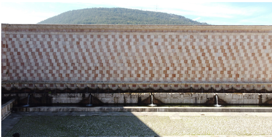
Fig.1.1 – Vista del prospetto meridionale della Fonte della Rivera, sullo sfondo la collina di Monte Luco
