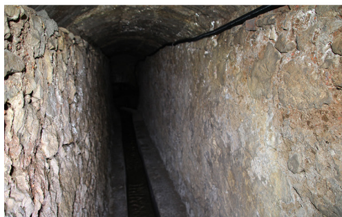
Fig. 1.1.1 – Le opere di presa ed i condotti di distribuzione nella galleria dietro il prospetto Nord ed il Prospetto Est della Fonte della Rivera.
