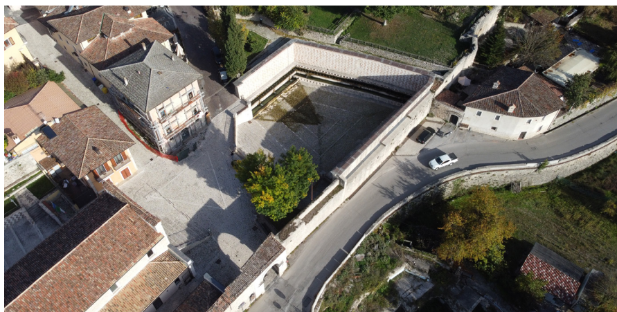
Fig.1.3 – Vista aerea della Fonte della Rivera, in basso a sinistra la chiesa di San Vito di Tornimparte, la porta urbana, le mura a cui si appoggia il prospetto meridionale della fontana; sulla sinistra le prime case del “Borgo Rivera”.
